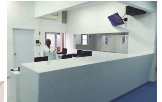
Obra de Remodelación Sala 8 - Estación de Enfermería
