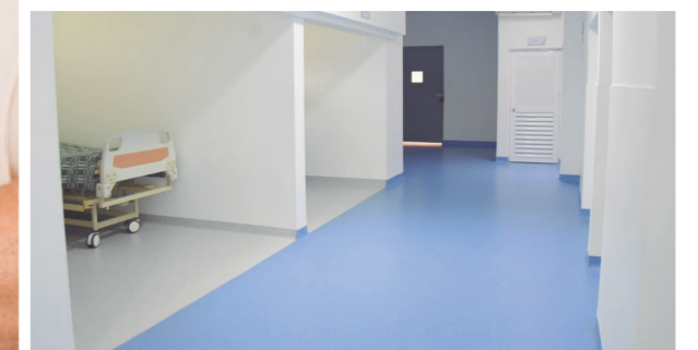
Obra de Remodelación Sala 8 - Zonas comunes y habitaciones
